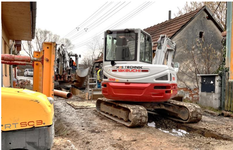
Foto: Proces výstavby kanalizácie
