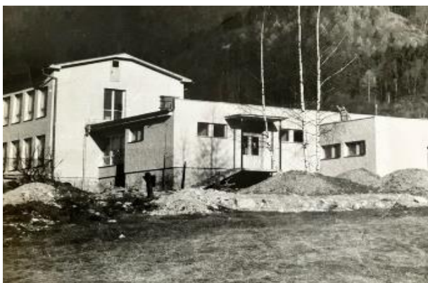
Foto: Výstavba budovy MŠ
